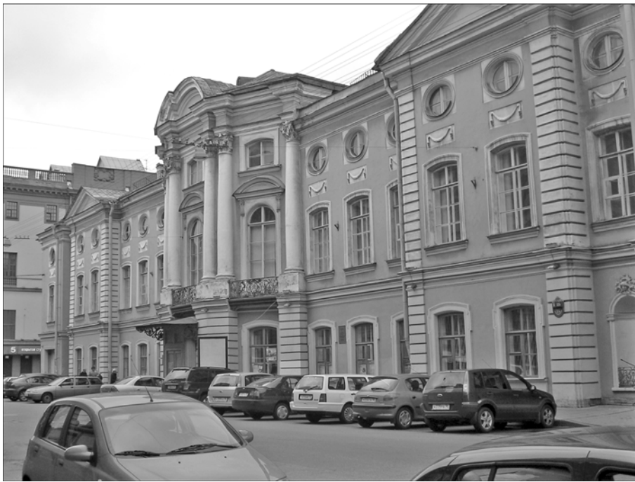
Рис. 1. Общий вид здания Музея гигиены. Санкт-Петербург, 2009 г.
